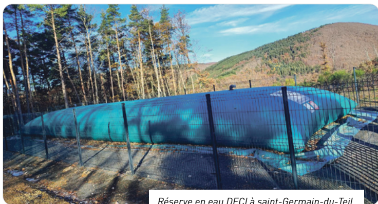
Réserve en eau DECI à saint-Germain-du-Teil
