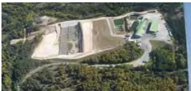
Figure 36 : Vue aérienne des installations du SDEE
